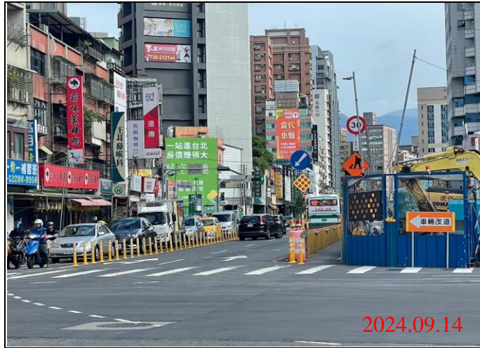
巡查日期地點：113.09.14/ Y21車站 照片說明：牌面設置狀況
