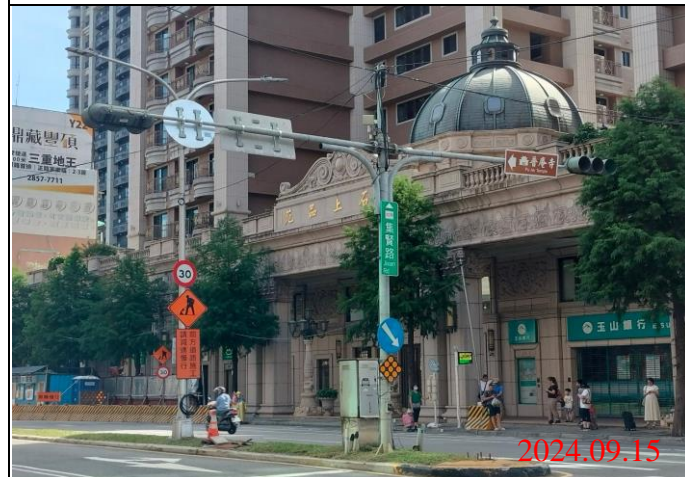
巡查日期地點：113.09.15/ Y22車站 照片說明：牌面設置狀況
