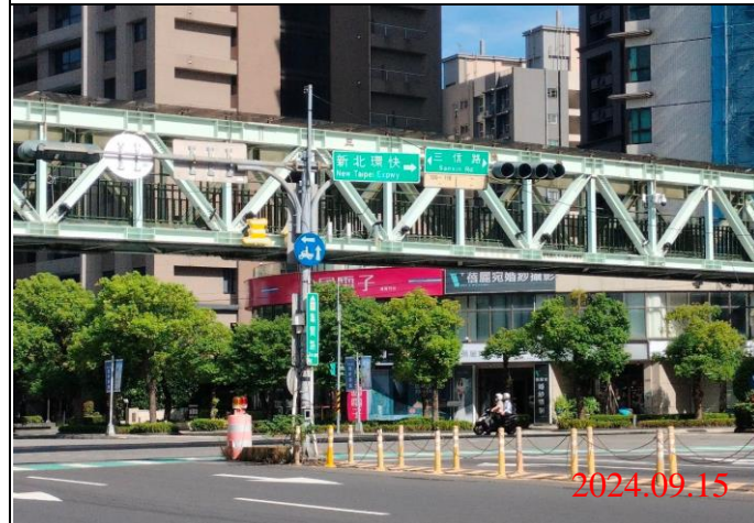
巡查日期地點：113.09.15/ Y23車站 照片說明：牌面設置狀況
