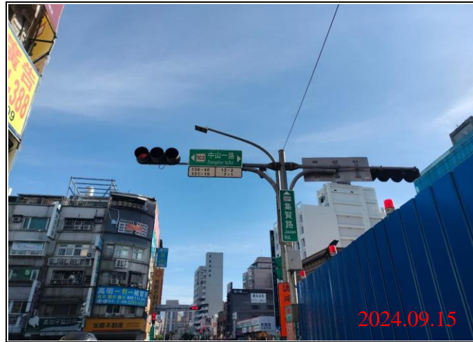
巡查日期地點：113.09.15/ Y21車站 照片說明：牌面設置狀況
