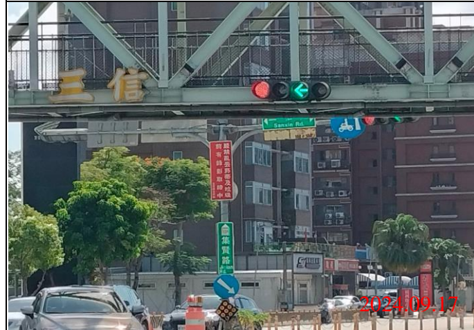
巡查日期地點：113.09.17/ Y23車站 照片說明：牌面設置狀況
