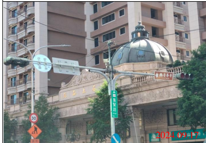
巡查日期地點：113.09.17/ Y22車站 照片說明：牌面設置狀況
