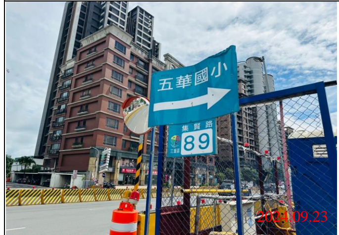
巡查日期地點：113.09.23/ Y23車站 照片說明：牌面設置狀況
