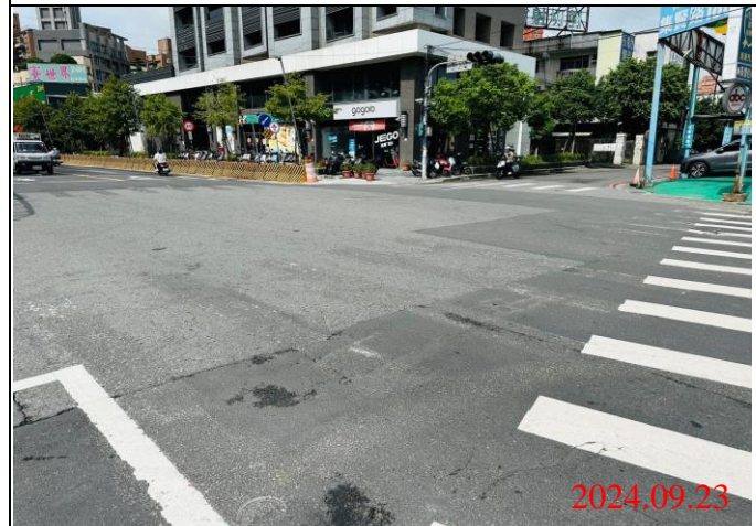
巡查日期地點：113.09.23/ Y22車站 照片說明：牌面設置狀況
