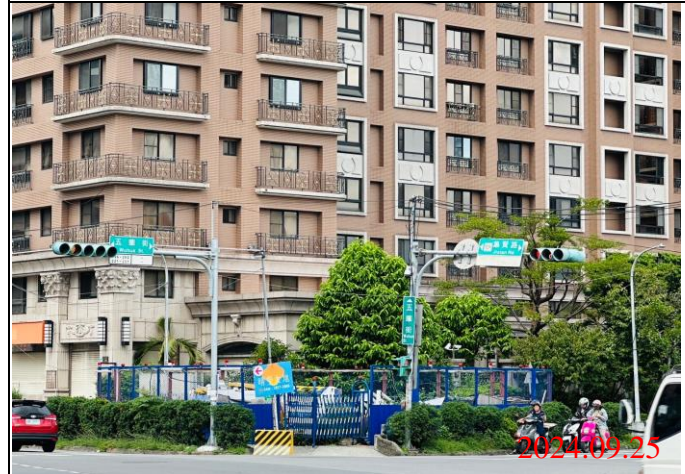
巡查日期地點：113.09.25/ Y22車站 照片說明：牌面設置狀況
