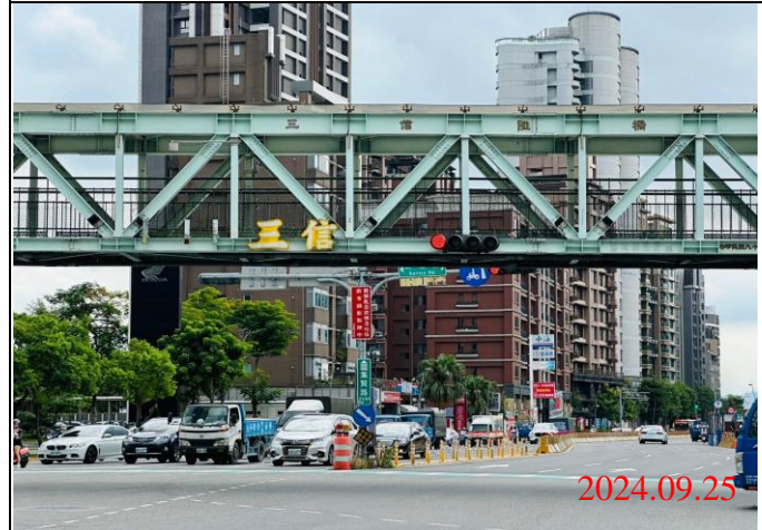
巡查日期地點：113.09.25/ Y23車站 照片說明：牌面設置狀況
