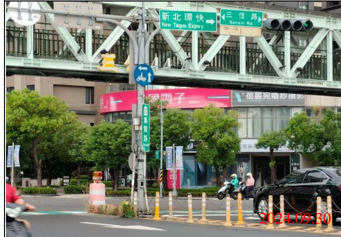
巡查日期地點：113.09.30/ Y23車站 照片說明：牌面設置狀況
