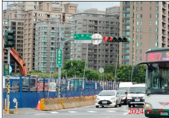
巡查日期地點：113.09.30/ Y22車站 照片說明：牌面設置狀況
