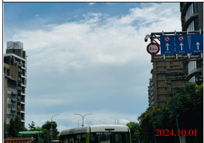
巡查日期地點：113.10.01/ Y23車站 照片說明：牌面設置狀況
