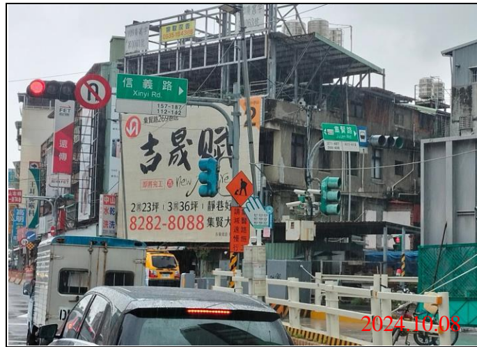
巡查日期地點：113.10.08 / Y21車站 照片說明：牌面設置狀況
