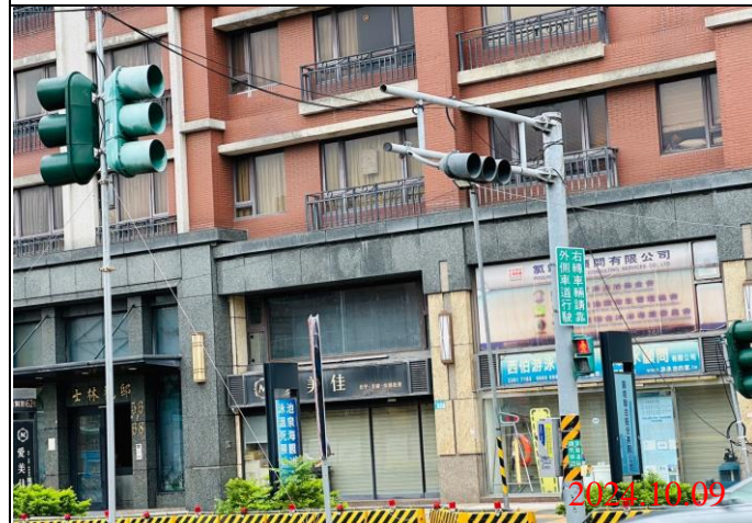
巡查日期地點：113.10.09 / Y22車站 照片說明：牌面設置狀況
