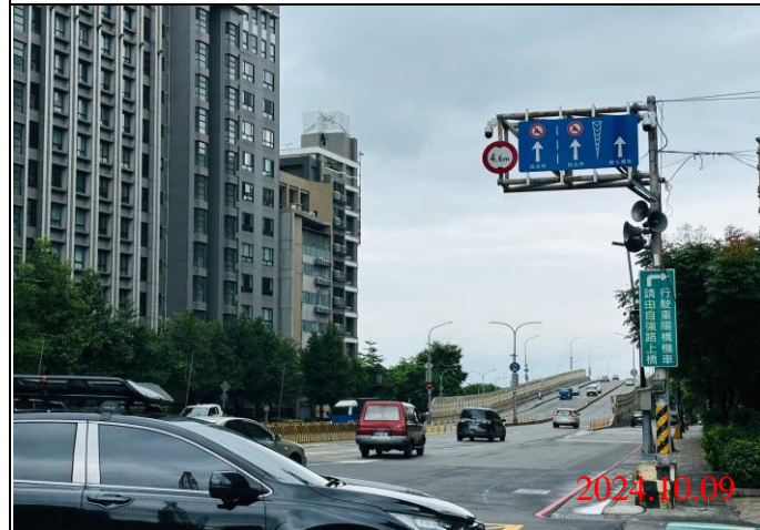
巡查日期地點：113.10.09 / Y23車站 照片說明：牌面設置狀況
