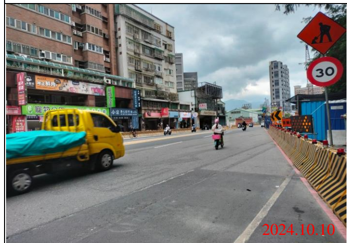
巡查日期地點：113.10.10 / Y22車站 照片說明：牌面設置狀況
