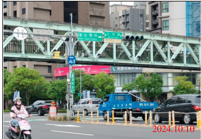
巡查日期地點：113.10.10 / Y23車站 照片說明：牌面設置狀況
