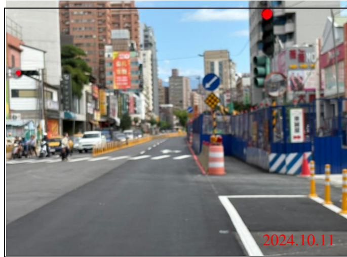
巡查日期地點：113.10.11 / Y21車站 照片說明：牌面設置狀況
