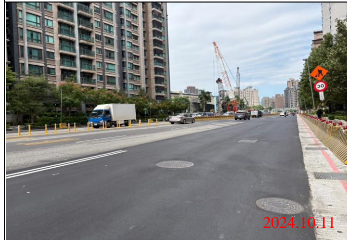
巡查日期地點：113.10.11 / Y23車站 照片說明：牌面設置狀況
