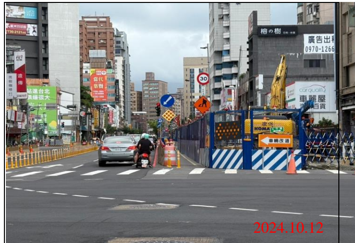
巡查日期地點：113.10.12 / Y21車站 照片說明：牌面設置狀況
