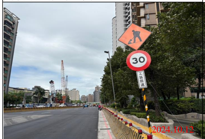
巡查日期地點：113.10.12 / Y23車站 照片說明：牌面設置狀況
