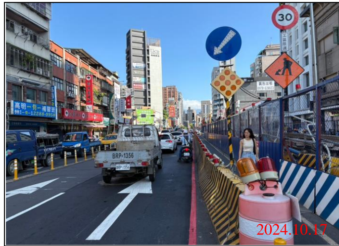
巡查日期地點：113.10.17/ Y21車站 照片說明：牌面設置狀況
