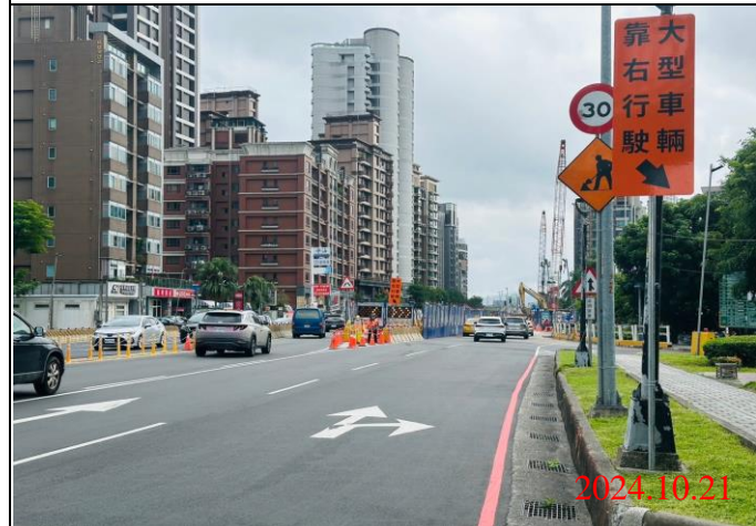
巡查日期地點：113.10.21/ Y23車站 照片說明：牌面設置狀況
