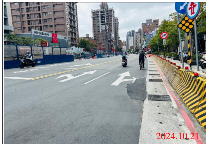
巡查日期地點：113.10.21/ Y22車站 照片說明：牌面設置狀況
