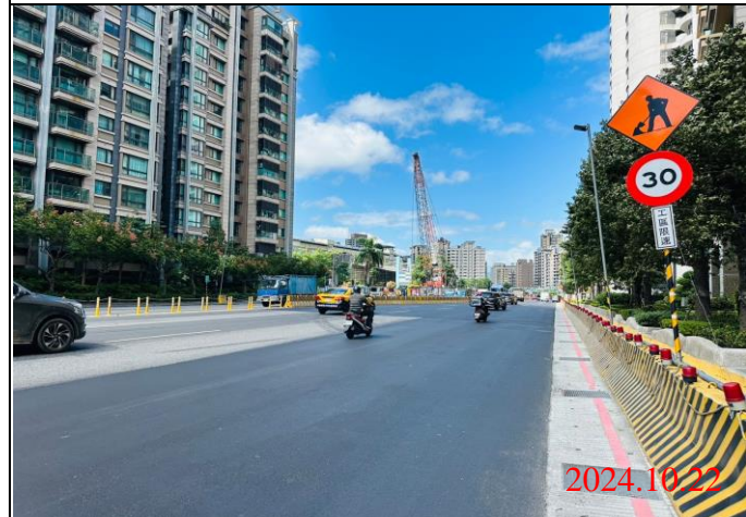
巡查日期地點：113.10.22/ Y23車站 照片說明：牌面設置狀況
