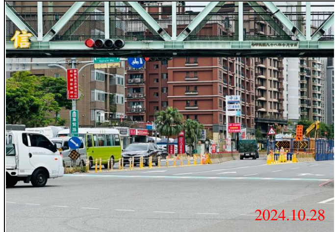
巡查日期地點：113.10.28/ Y23車站 照片說明：牌面設置狀況
