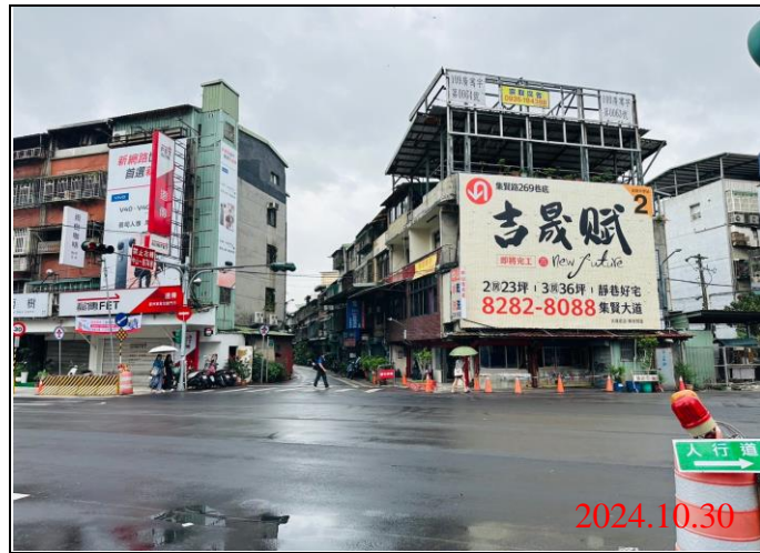
巡查日期地點：113.10.30/ Y21車站 照片說明：牌面設置狀況
