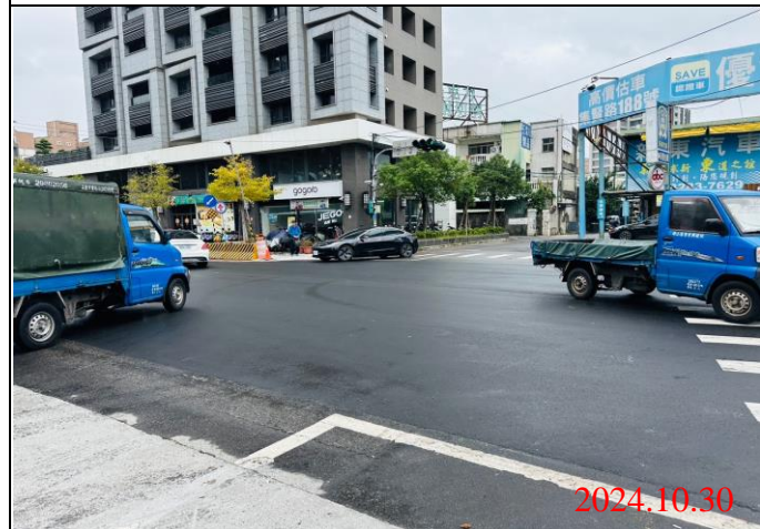
巡查日期地點：113.10.30/ Y22車站 照片說明：牌面設置狀況
