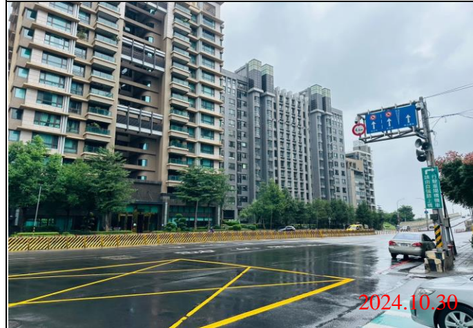
巡查日期地點：113.10.30/ Y23車站 照片說明：牌面設置狀況
