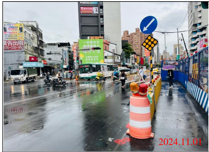
巡查日期地點：113.11.01/ Y21車站 照片說明：牌面設置狀況
