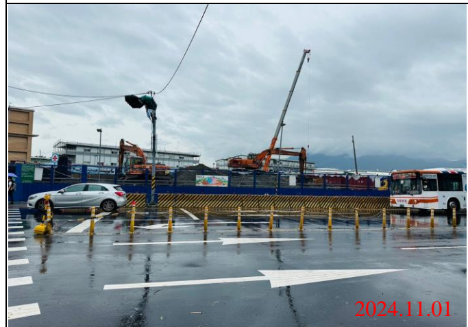
巡查日期地點：113.11.01/ Y22車站 照片說明：牌面設置狀況
