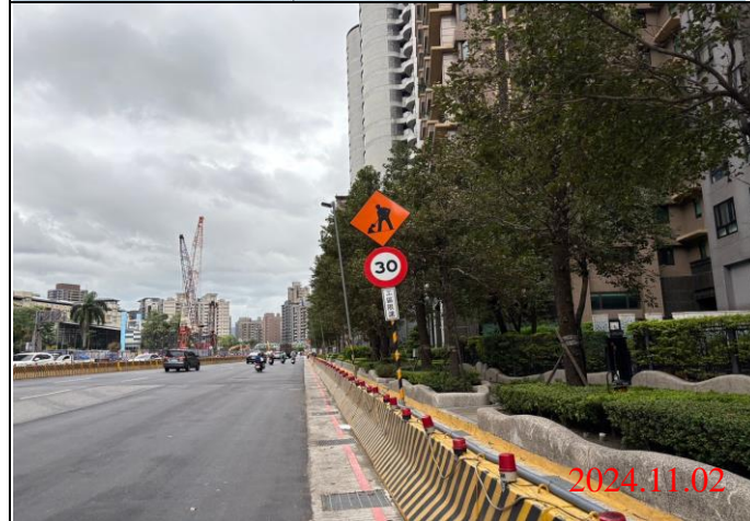
巡查日期地點：113.11.02/ Y23車站 照片說明：牌面設置狀況
