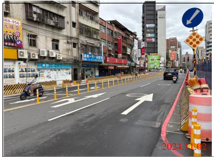
巡查日期地點：113.11.02/ Y21車站 照片說明：牌面設置狀況
