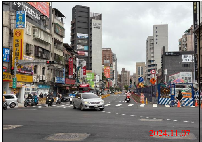
巡查日期地點：113.11.07 /Y21車站 照片說明：牌面設置狀況
