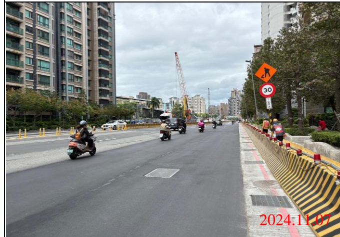
巡查日期地點：113.11.07 /Y23車站 照片說明：牌面設置狀況
