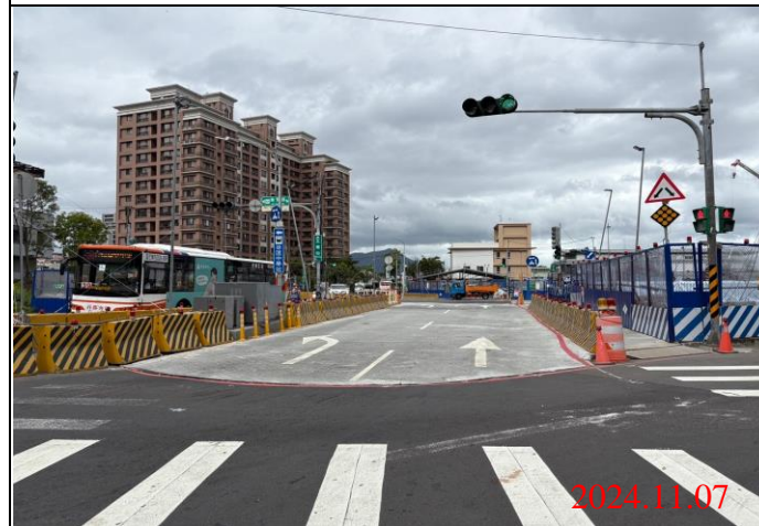
巡查日期地點：113.11.07/Y22車站 照片說明：牌面設置狀況
