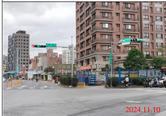
巡查日期地點：113.11.10/ Y22車站 照片說明：牌面設置狀況
