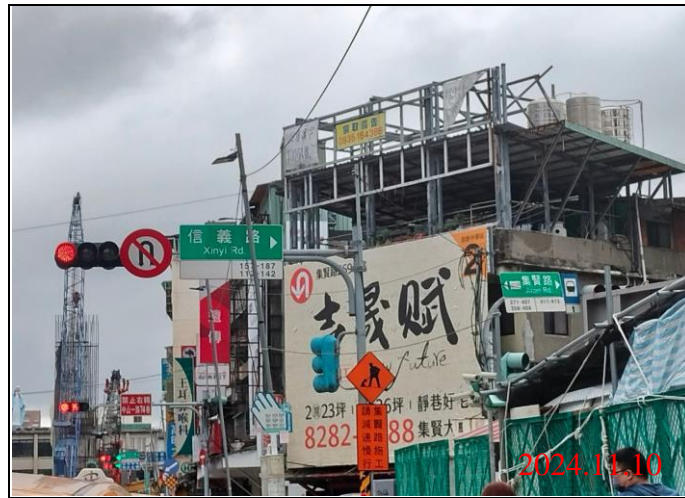
巡查日期地點：113.11.10/ Y21車站 照片說明：牌面設置狀況
