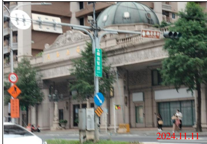
巡查日期地點：113.11.11/ Y22車站 照片說明：牌面設置狀況
