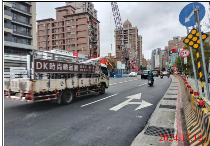
巡查日期地點：113.11.12/ Y22車站 照片說明：牌面設置狀況
