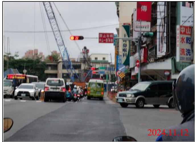
巡查日期地點：113.11.12/ Y21車站 照片說明：牌面設置狀況
