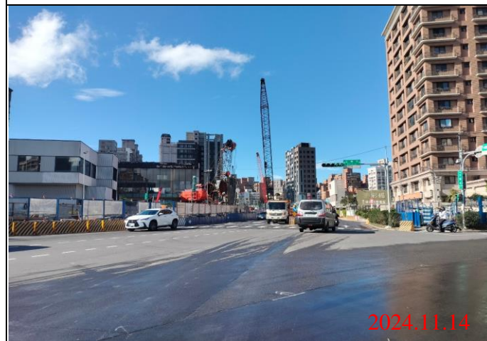
巡查日期地點：113.11.14/ Y22車站 照片說明：牌面設置狀況
