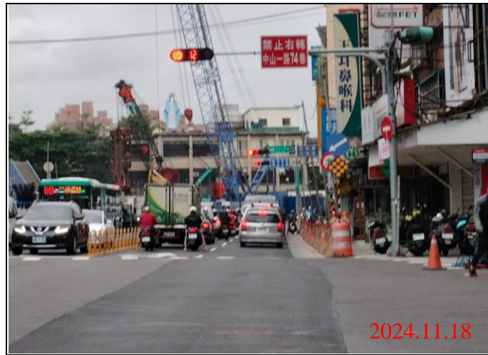
巡查日期地點：113.11.18/ Y21車站 照片說明：牌面設置狀況
