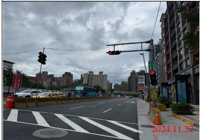
巡查日期地點：113.11.22/ Y23車站 照片說明：牌面設置狀況
