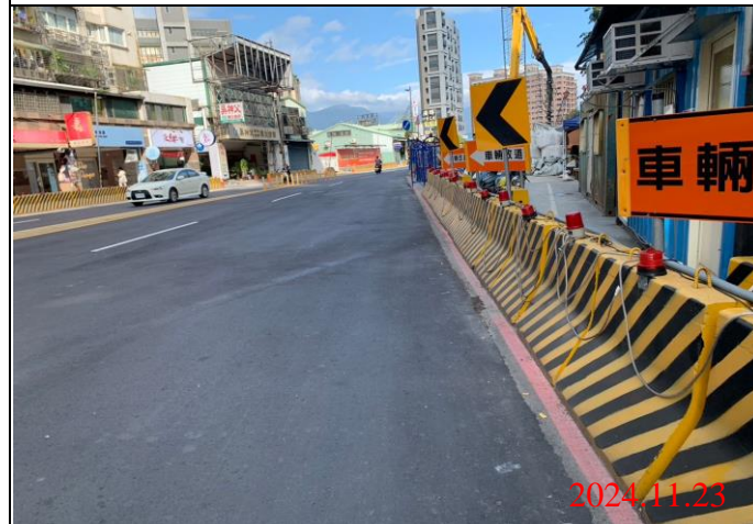
巡查日期地點：113.11.23/ Y22車站 照片說明：牌面設置狀況
