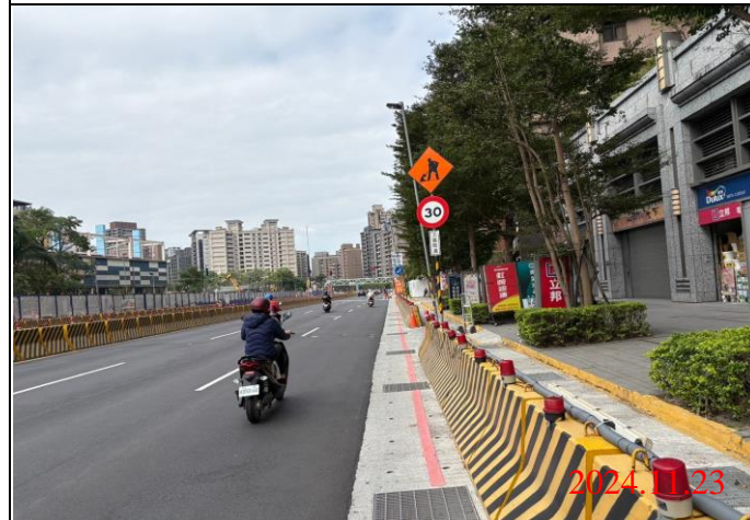
巡查日期地點：113.11.23/ Y23車站 照片說明：牌面設置狀況
