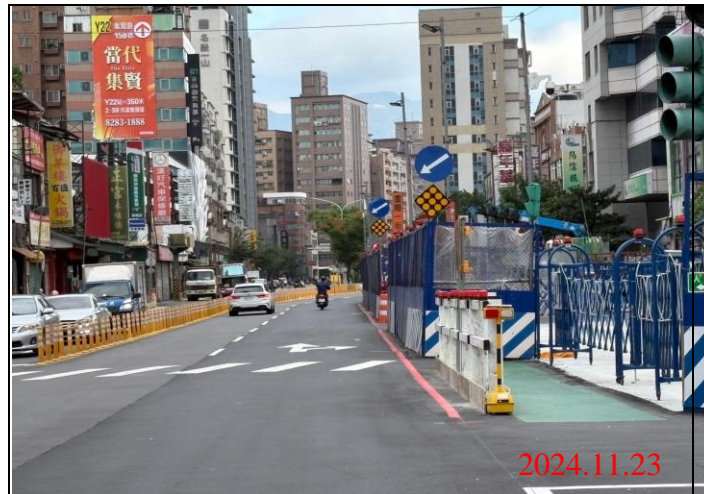
巡查日期地點：113.11.23/ Y21車站 照片說明：牌面設置狀況
