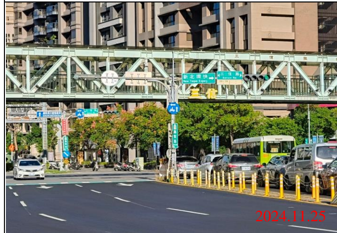
巡查日期地點：113.11.25/ Y23車站 照片說明：牌面設置狀況
