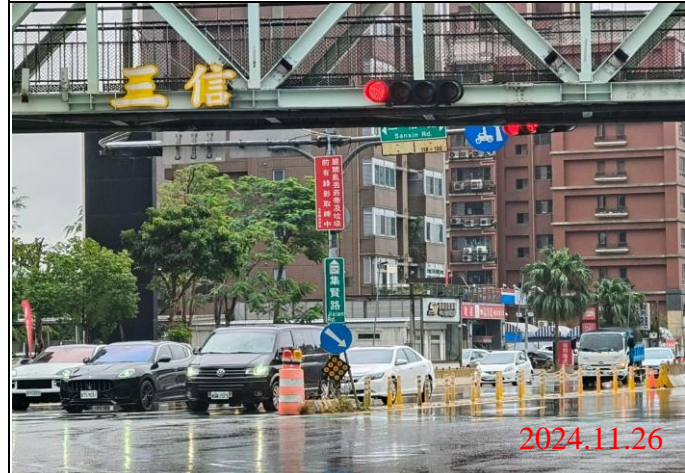
巡查日期地點：113.11.26/ Y23車站 照片說明：牌面設置狀況
