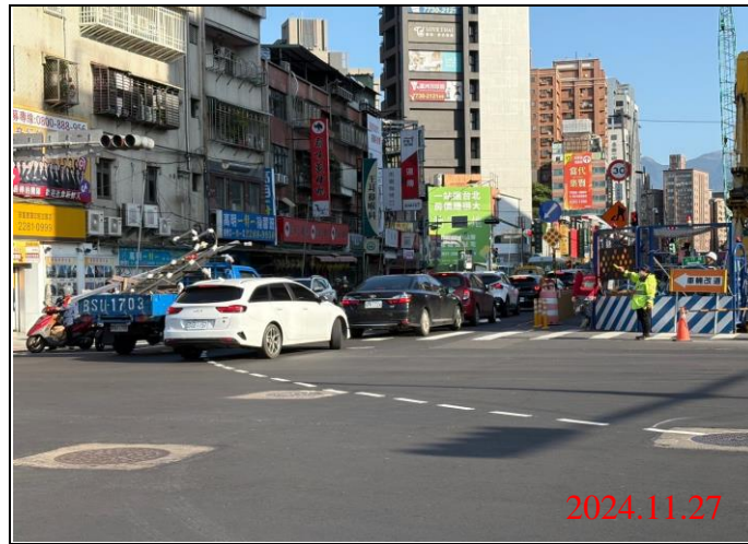
巡查日期地點：113.11.27/ Y21車站 照片說明：牌面設置狀況
