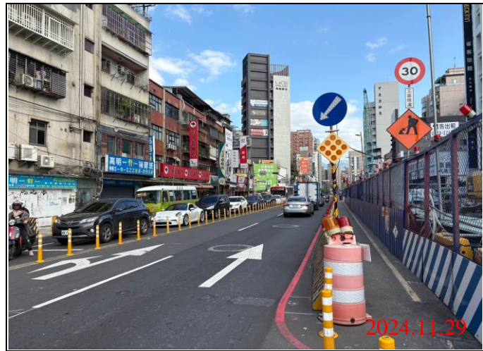
巡查日期地點：113.11.29/ Y21車站 照片說明：牌面設置狀況
