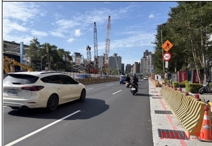
巡查日期地點：113.11.30/ Y23車站 照片說明：牌面設置狀況
