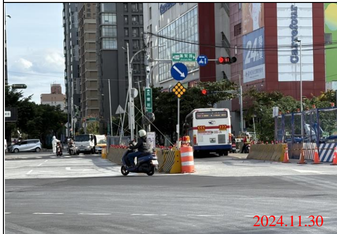
巡查日期地點：113.11.30/ Y22車站 照片說明：牌面設置狀況
