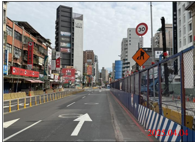
巡查日期地點：114.04.04 / Y21車站 照片說明：牌面設置狀況
