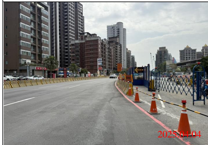
巡查日期地點：114.04.04 / Y23車站 照片說明：牌面設置狀況
