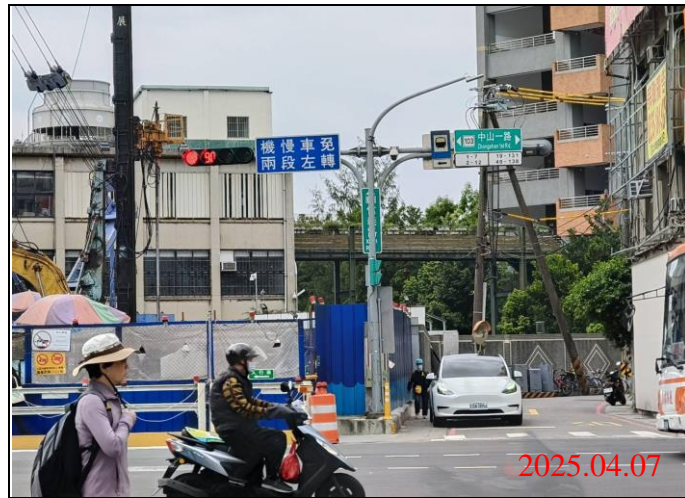
巡查日期地點：114.04.07 / Y21車站 照片說明：牌面設置狀況
