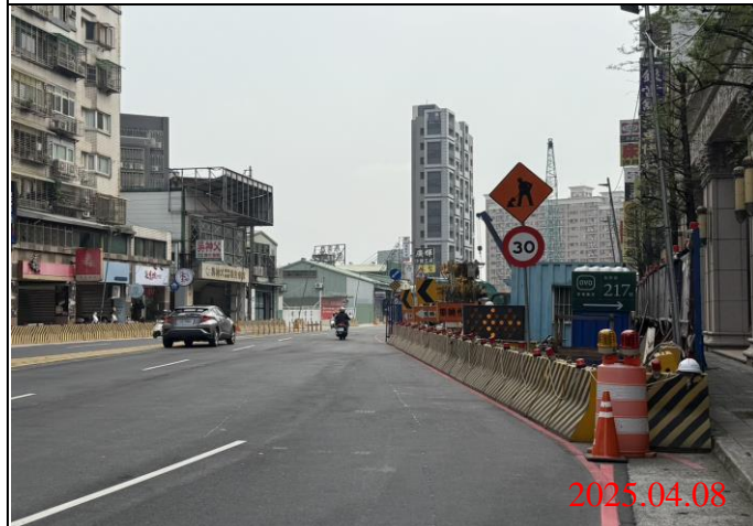
巡查日期地點：114.04.08 / Y22車站 照片說明：牌面設置狀況
