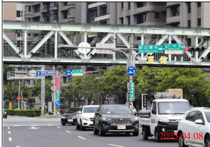
巡查日期地點：114.04.08 / Y23車站 照片說明：牌面設置狀況
