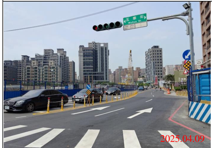
巡查日期地點：114.04.09 / Y22車站 照片說明：牌面設置狀況
