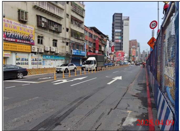
巡查日期地點：114.04.09 / Y21車站 照片說明：牌面設置狀況
