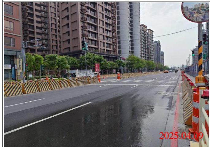
巡查日期地點：114.04.09 / Y23車站 照片說明：牌面設置狀況
