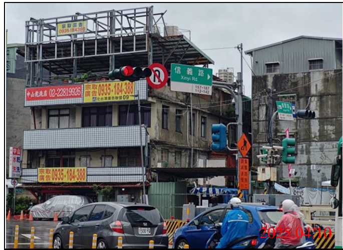
巡查日期地點：114.04.10 / Y21車站 照片說明：牌面設置狀況
