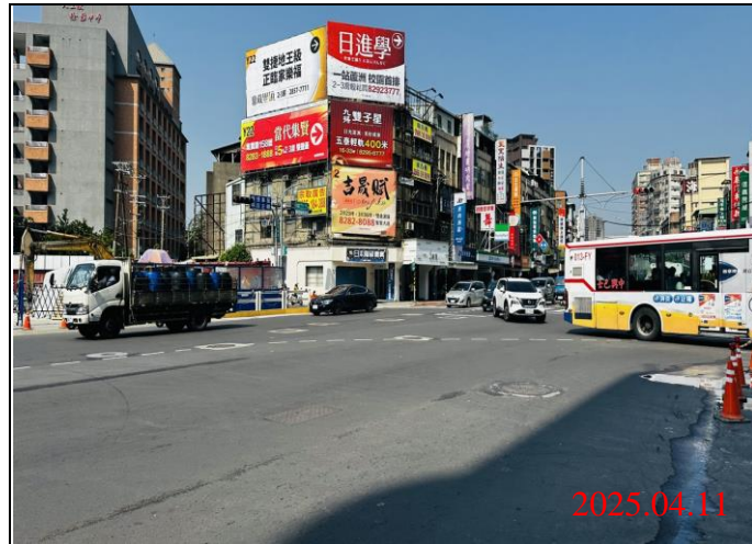
巡查日期地點：114.04.11 / Y21車站 照片說明：路面狀況
