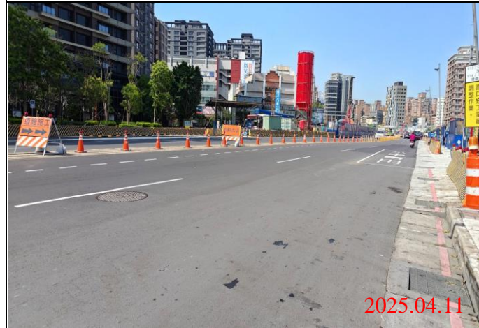
巡查日期地點：114.04.11 / Y22車站 照片說明：路面狀況
