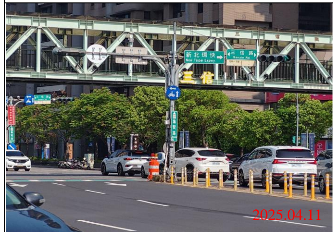
巡查日期地點：114.04.11 / Y23車站 照片說明：牌面設置狀況
