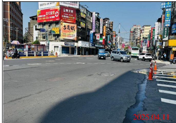
巡查日期地點：114.04.11 / Y21車站 照片說明：路面狀況
