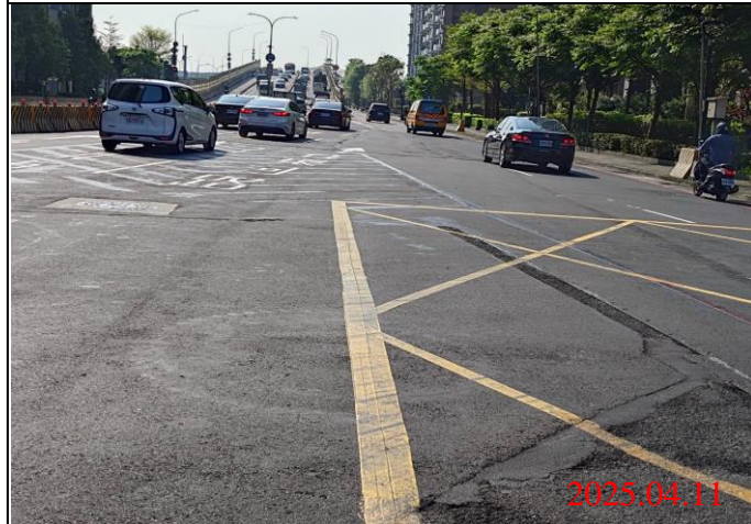
巡查日期地點：114.04.11 / Y23車站 照片說明：路面狀況
