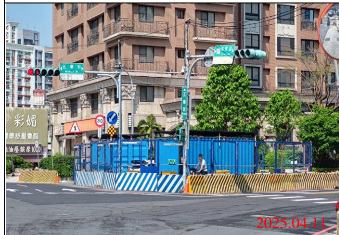
巡查日期地點：114.04.11 / Y22車站 照片說明：牌面設置狀況
