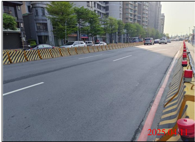
巡查日期地點：114.04.11 / Y23車站 照片說明：路面狀況
