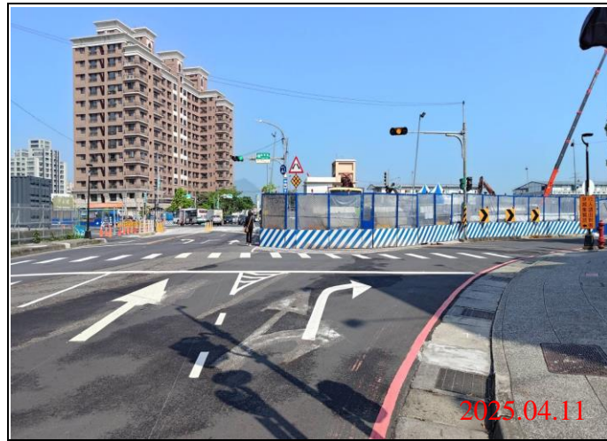
巡查日期地點：114.04.11 / Y22車站 照片說明：路面狀況
