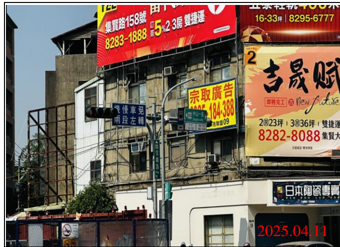
巡查日期地點：114.04.11 / Y21車站 照片說明：牌面設置狀況
