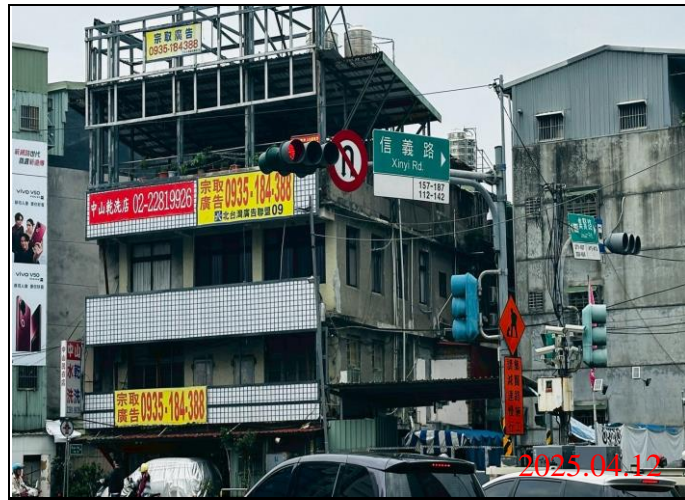
巡查日期地點：114.04.12 / Y21車站 照片說明：牌面設置狀況
