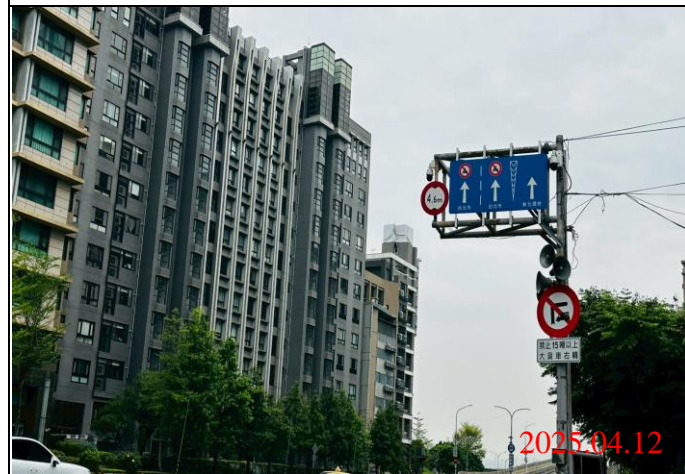
巡查日期地點：114.04.12 / Y23車站 照片說明：牌面設置狀況
