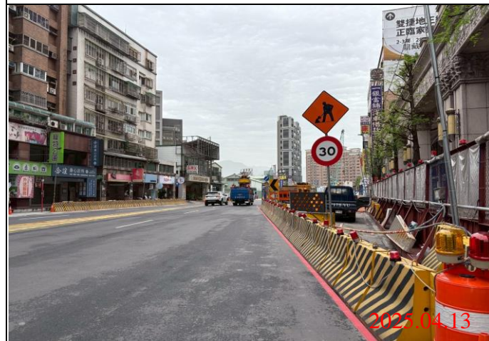
巡查日期地點：114.04.13 / Y22車站 照片說明：牌面設置狀況
