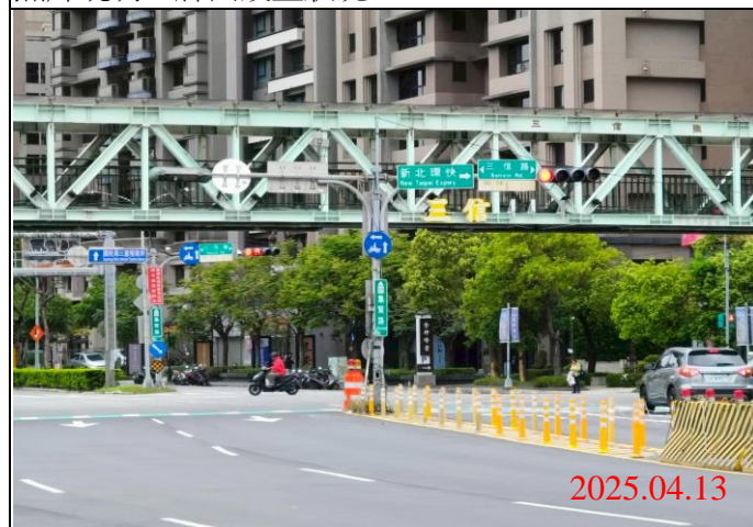
巡查日期地點：114.04.13 / Y23車站 照片說明：牌面設置狀況
