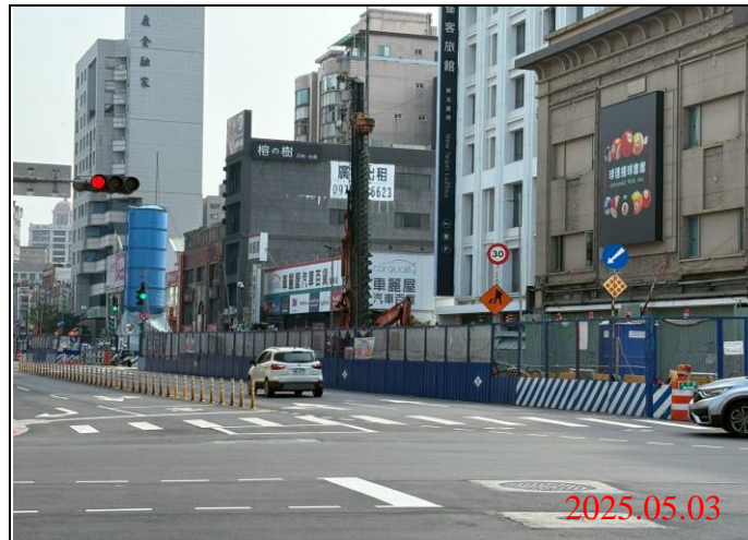
巡查日期地點：114.05.03 / Y21車站 照片說明：牌面設置狀況
