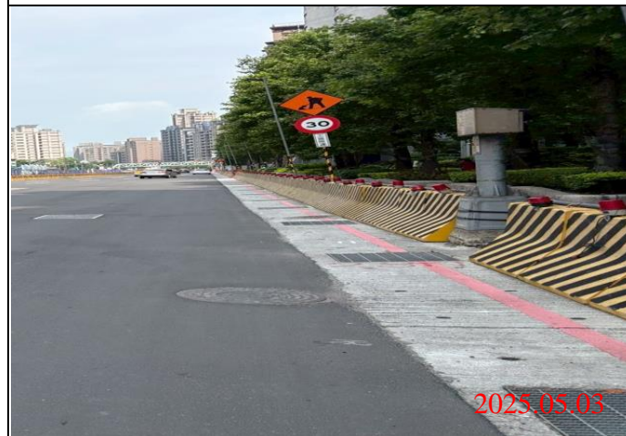
巡查日期地點：114.05.03 / Y23車站 照片說明：牌面設置狀況
