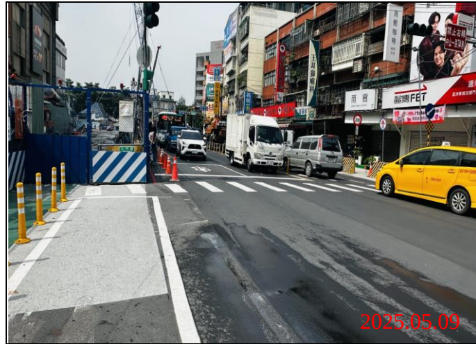
巡查日期地點：114.05.09 / Y21車站 照片說明：牌面設置狀況
