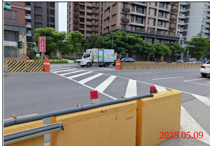
巡查日期地點：114.05.09 / Y23車站 照片說明：牌面設置狀況
