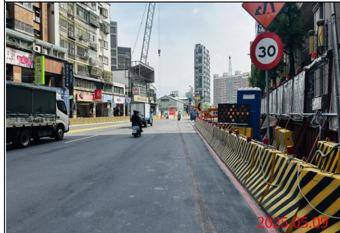
巡查日期地點：114.05.09 / Y22車站 照片說明：牌面設置狀況
