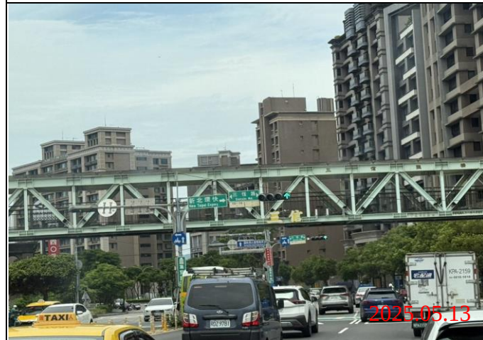
巡查日期地點：114.05.13/ Y23車站 照片說明：牌面設置狀況
