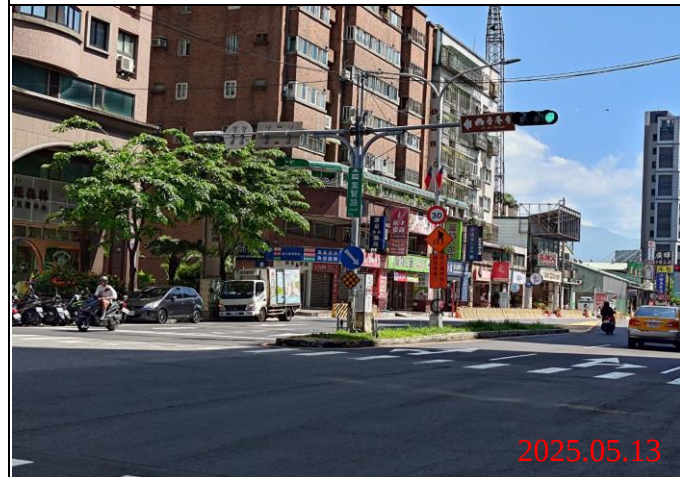
巡查日期地點：114.05.13/ Y22車站 照片說明：牌面設置狀況
