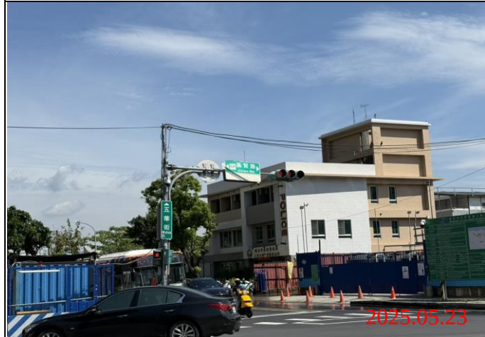
巡查日期地點：114.05.23/ Y22車站 照片說明：牌面設置狀況
