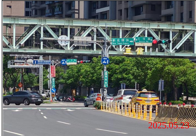
巡查日期地點：114.05.23/ Y23車站 照片說明：牌面設置狀況
