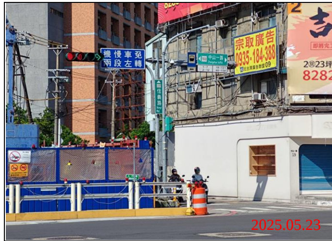
巡查日期地點：114.05.23/ Y21車站 照片說明：牌面設置狀況
