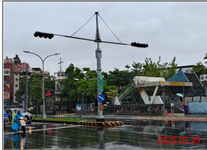
巡查日期地點：114.05.29/ Y21車站 照片說明：牌面設置狀況
