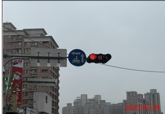
巡查日期地點：114.05.29/ Y22車站 照片說明：牌面設置狀況
