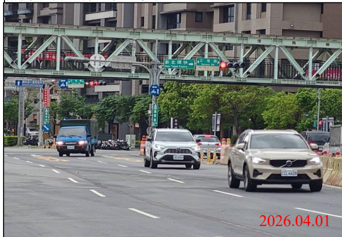
巡查日期地點：115.04.01/ Y23車站 照片說明：牌面設置狀況
