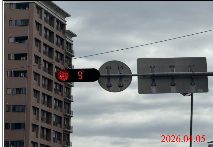
巡查日期地點：115.04.05/ Y22車站 照片說明：牌面設置狀況
