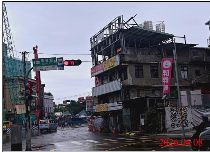
巡查日期地點：115.04.08/ Y21車站 照片說明：牌面設置狀況
