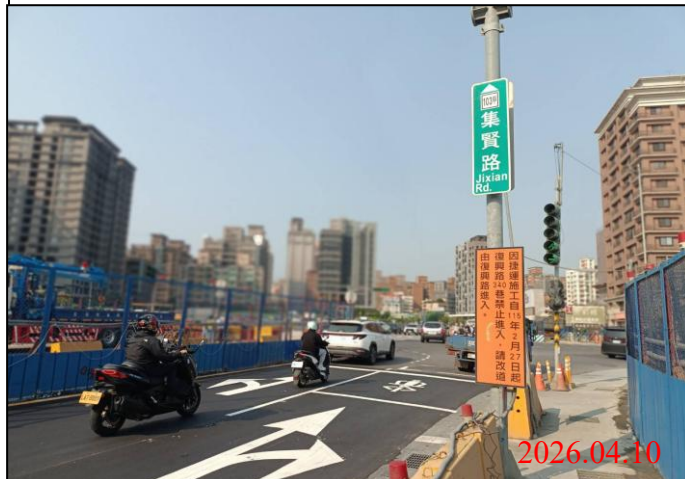
巡查日期地點：115.04.10/ Y22車站 照片說明：牌面設置狀況
