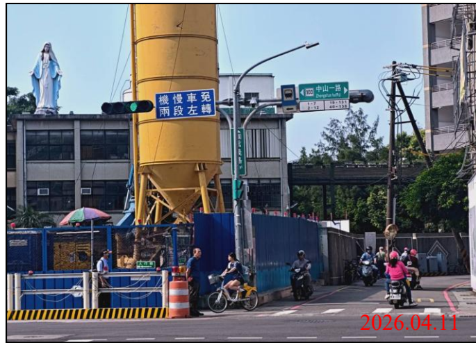
巡查日期地點：115.04.11/ Y21車站 照片說明：牌面設置狀況
